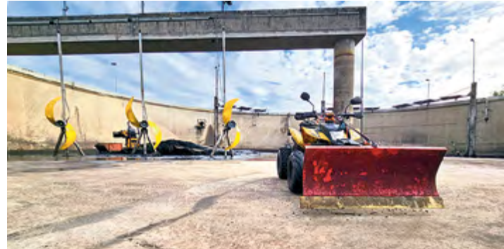
Mit Quad und Schiebescbild zum besenreinen Klärbecken. Auch die gelben Rührwerke wurden gereinigt.
