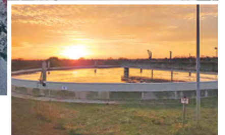
Im Belebungsbecken mit 35 Metern Durchmesser rückte das Team in sechs Metern Tiefe dem Klärschlamm zu Leibe. Im gereinigten Belebungsbecken (kleines Foto) schmeckts den Mikroorganismen wieder richtig gut.
