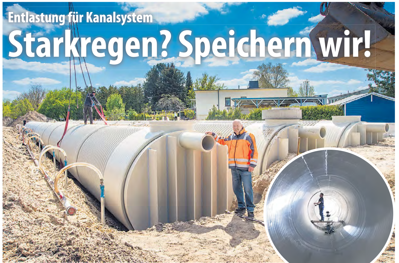
NUWAB-Vorarbeiter Heiko Stein an den Speicherrohren, die millimetergenau vom Kran verlegt wurden.
