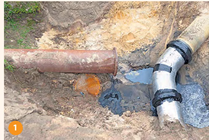
Der neue Zulauf des Abwassers zur Kläranlage. Fotos (4): SPREE-PR/Friedel
